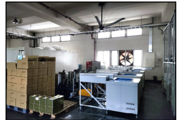
七月- 安裝大型吊扇，改善空氣流通，提升工作環境舒適度。
